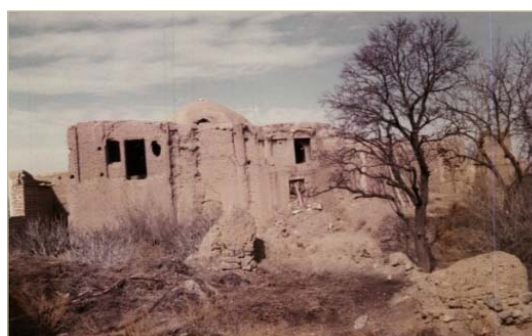
تصویر ۴. نمای بیرونی خانه ملاصدرا قبل از مرمت (پرونده ثبتی، میراث فرهنگی)
