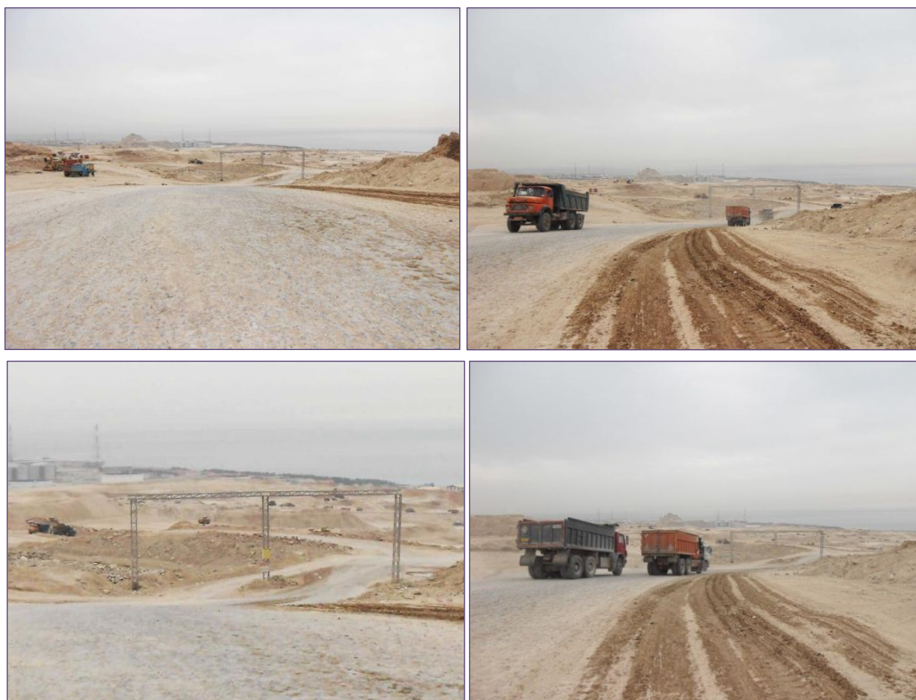
تصویر ۵: مکان ورودی اصلی (با سازه فلزی مشخص شده است)
